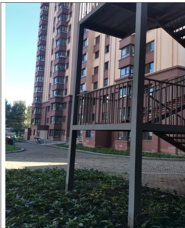
东侧（悦然臻城小区）
